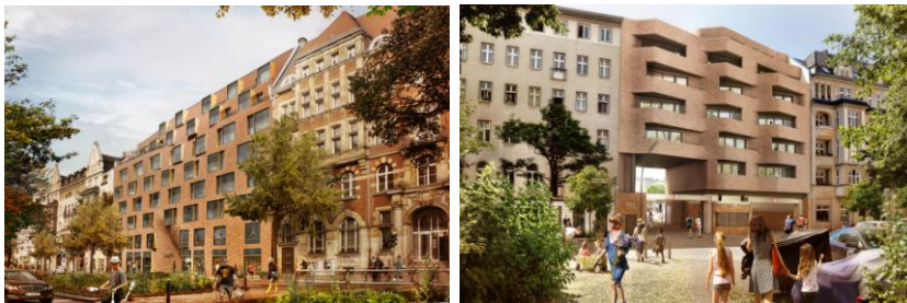
Die Neubauten in der Hauptstraße (links) und in der Belziger Straße (rechts) greifen die namensgebende Backsteinfassade von BRICKS Berlin Schöneberg auf
